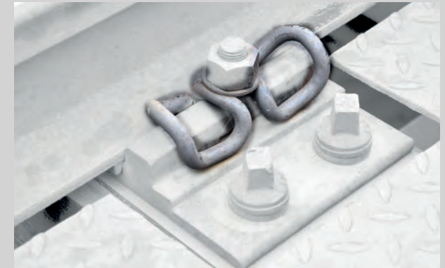
Pružná svěrka (zvýrazněná část)
